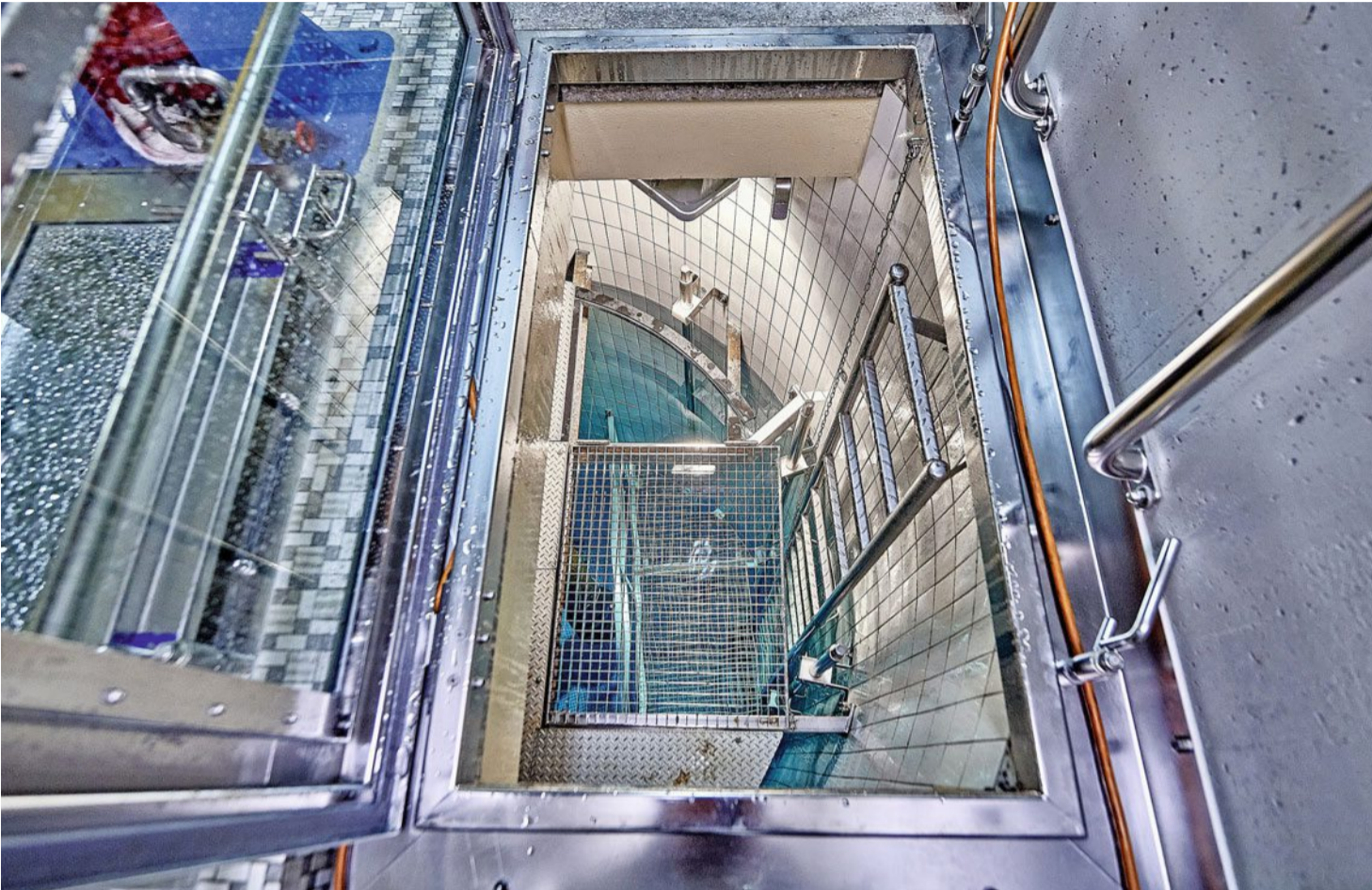
Das Seeland ist besonders betroffen – aber auch andere Regionen. In über 80 Gemeinden konnten Abbauprodukte von Chlorothalonil nachgewiesen werden. Hier die Fassung in Worben. ADRIAN MOSER
