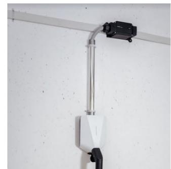
Es ist weder ein FI Schutzschalter (ein RCD Typ B 30mA AC / 6mA DC bereits in Ladestation integriert) noch ein separater Leitungsschutzschalter pro Ladestation notwendig.
